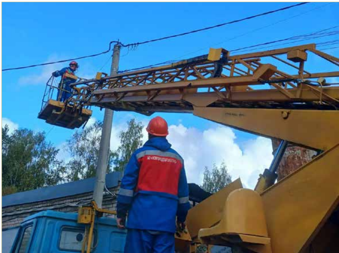
За пять лет заменено и построено 547 км современных и надёжных линий электропередачи.
